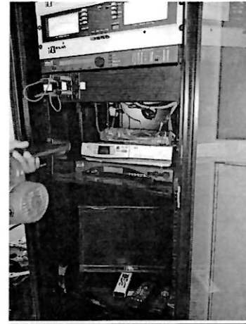
Limpeza de los equipos del rack de transmisión
