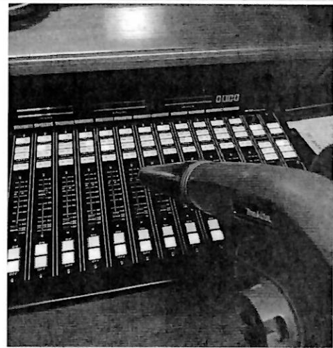
Limpeza de consola de transmisión
