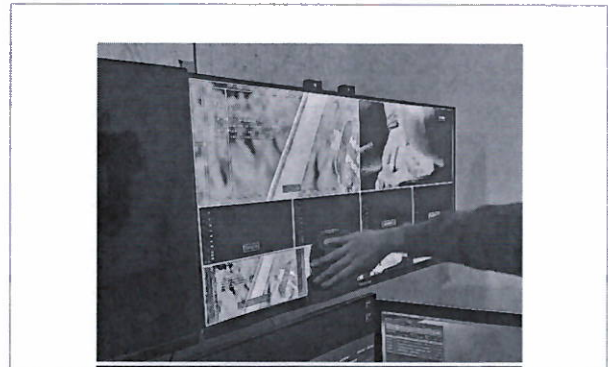
Remoción de polvo al monitor del multiview
