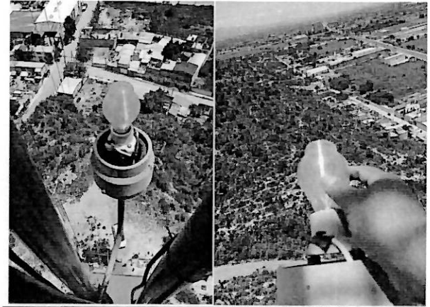
Cambio de luces de obstrucción de la torre de transmisión de FM
