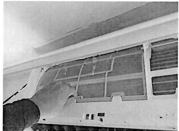
Limpieza de los filtros de los climas y del equipo en general
